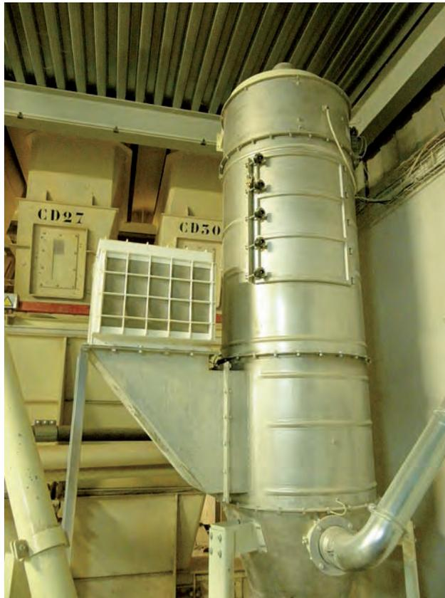
**ILUSTRACIÓN 22.** Montaje de venteo sin llama en filtro de mangas
