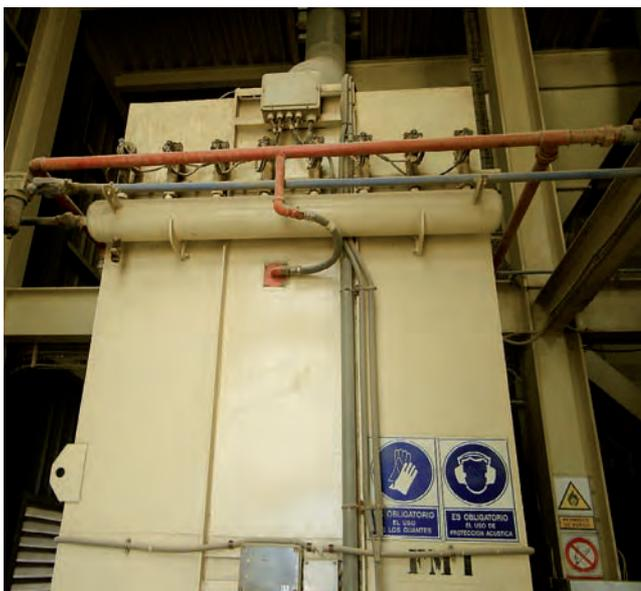
*ILUSTRACIÓN 28. Extinción de incendios en filtro de mangas (Por cortesía de Nanta)*
