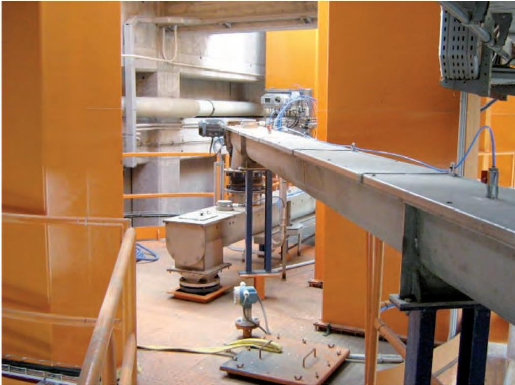
*ILUSTRACIÓN 19. Montaje de venteo en silos y conducto al exterior
